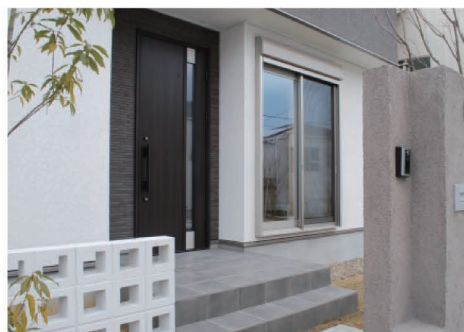
2階をオーバーハングさせて、 玄関とリビング窓の底とすることで、 スッキリと美しいファサードを作りだしています。
