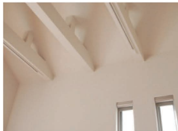
リビング側の吹抜け天井は「梁出し仕上げ」で、照明用のライティングレールを設けています。壁面のスリット窓など趣のあるリビングライフをお楽しみいただける設えです。
